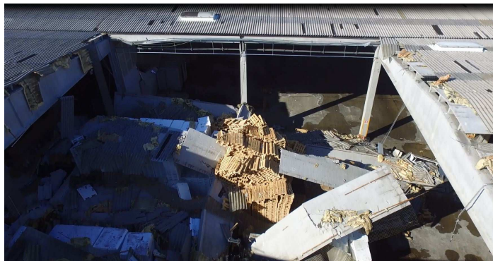
Foto 1: La porzione crollata fortunatamente senza vittime
