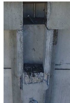
Foto 2: il capitello e la crosta di calcestruzzo che ha ceduto.
