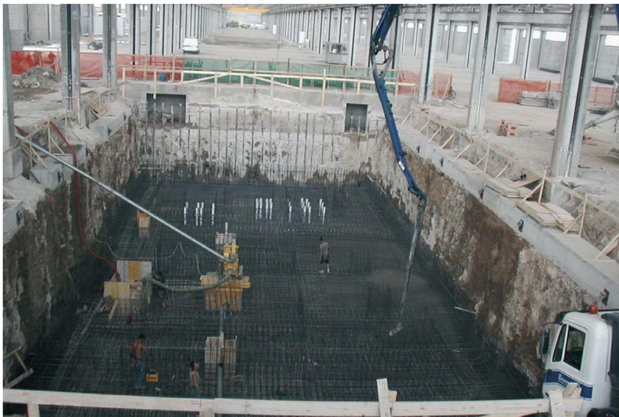
Torbole Casaglia: vista della vasca del laminatoio e posa delle armature della platea.
