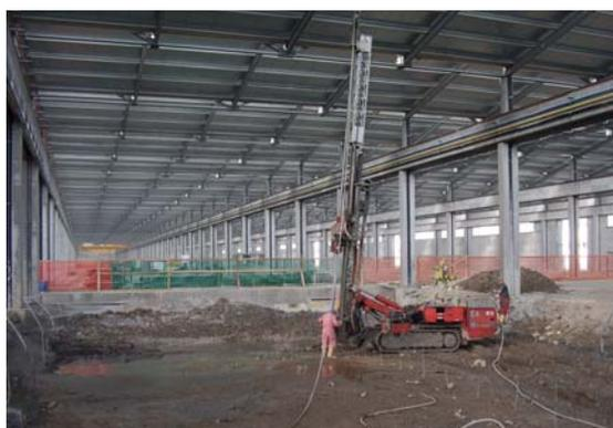
Cantiere in Torbole Casaglia: realizzazione colonne di tampone all'interno del capannone.
