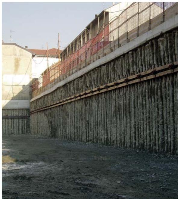
*Scavo di sbancamento completato.
