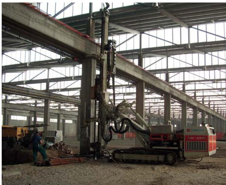
In presenza di situazioni particolari, per la connessione dei pali alla struttura da consolidare è sufficiente la tensione di aderenza sviluppata dal palo nel suo attraversamento del supporto.
