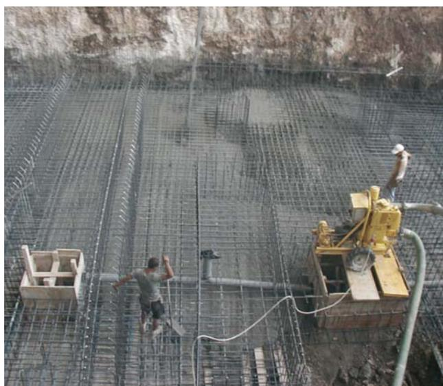
La perfetta tenuta idraulica delle colonne perimetrali e di fondo hanno consentito la posa delle armature nella massima efficienza.
