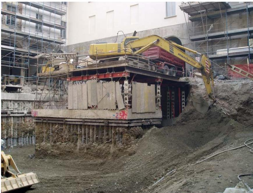
Realizzazione dei pali verticali, della trave di coronamento in c.a. e del primo anello di contrasti con barre Dywidag.
