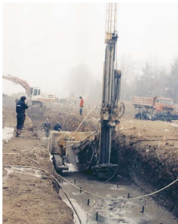
*Realizzazione di colonne portanti con armatura in barra piena per muro in elevazione;*
