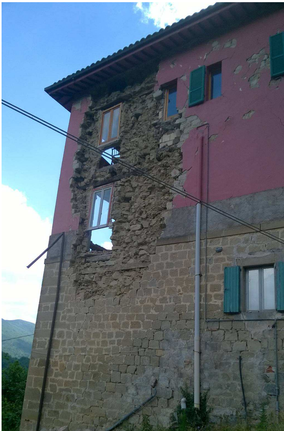
FOTO 10: Estrema fragilità della tipologia muraria.
