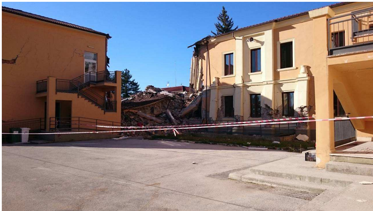
FOTO 1: Importanza della regolarità in pianta : Scuola di Amatrice.
