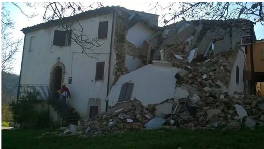
FOTO 6: Intervento con intonaco armato: Sarnano, loc. Terro. Due edifici simili; quello di sinistra però è stato trattato con intonaco armato ed ha resistito, mentre quello di destra no, ed è collassato.
