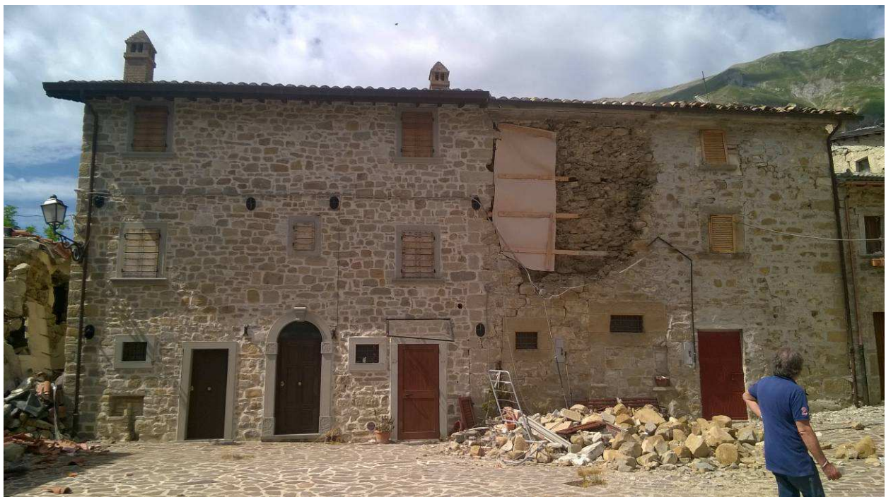
FOTO 4 e 4.1: due interventi concomitanti: catene e giunti: Montegallo, frazione Colle.
