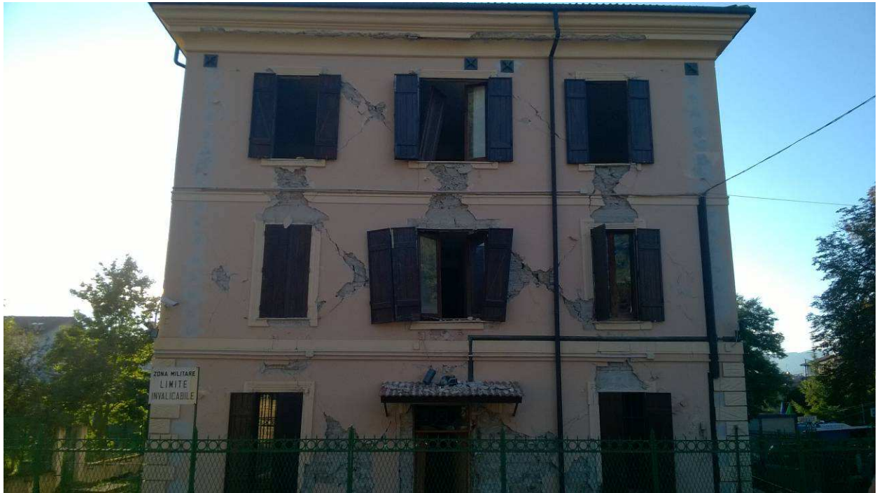
FOTO 3: Importanza delle catene (effetto scatola) : Caserma dei Carabinieri di Amatrice.
