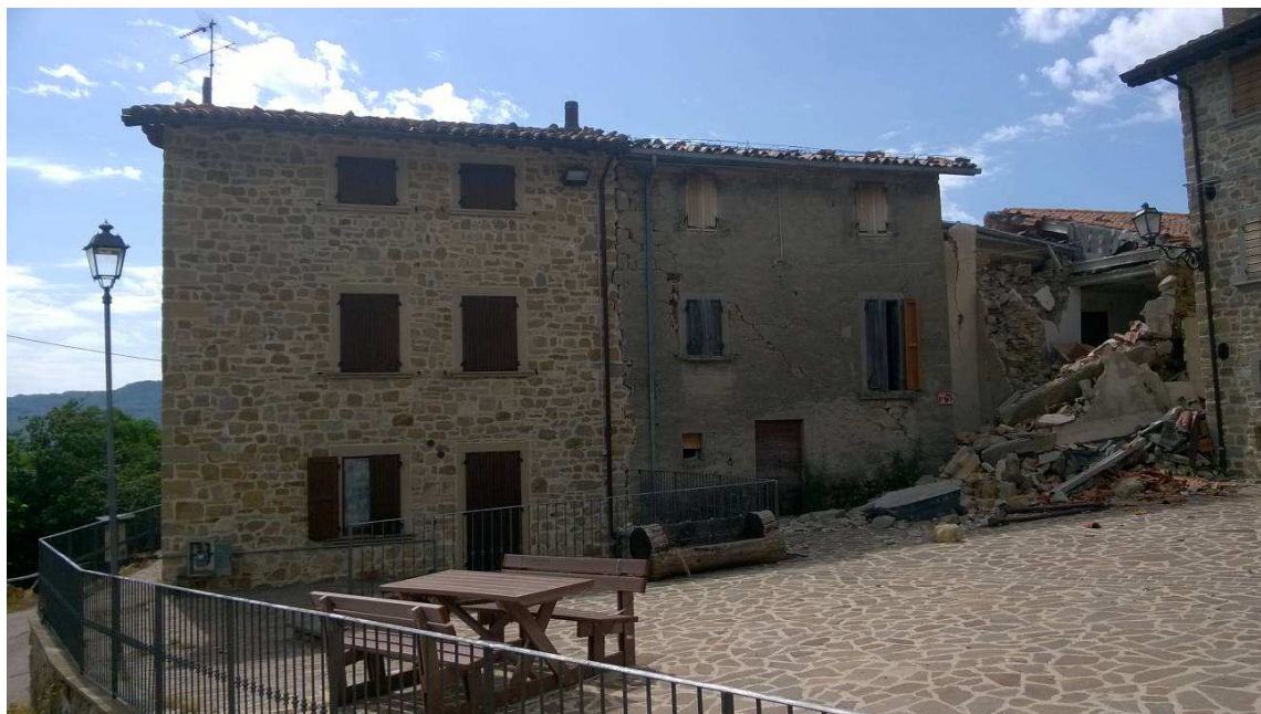
FOTO 5: buona manutenzione dell'edificio con chiusura dei giunti: Montegallo, frazione Colle. Nella stessa piazza delle foto precedenti, anche questo edificio, pur essendo di estremità (e quindi potenzialmente più esposto) ha ben resistito, contrariamente a quelli adiacenti.
