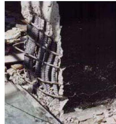
**Esempio rottura al piede** di un pilastro con espulsione cls e piegatura dei ferri
