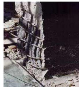
**Esempio rottura al piede di un pilastro con espulsione cls e piegatura dei ferri**
